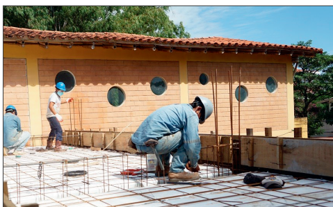
Nouvelle aile à côté du bâtiment de 2014 : une structure solide ...
